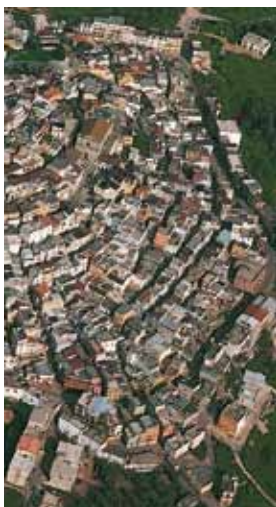
Fotografia aerea del centro storico e Chiesa di San Cirillo.
